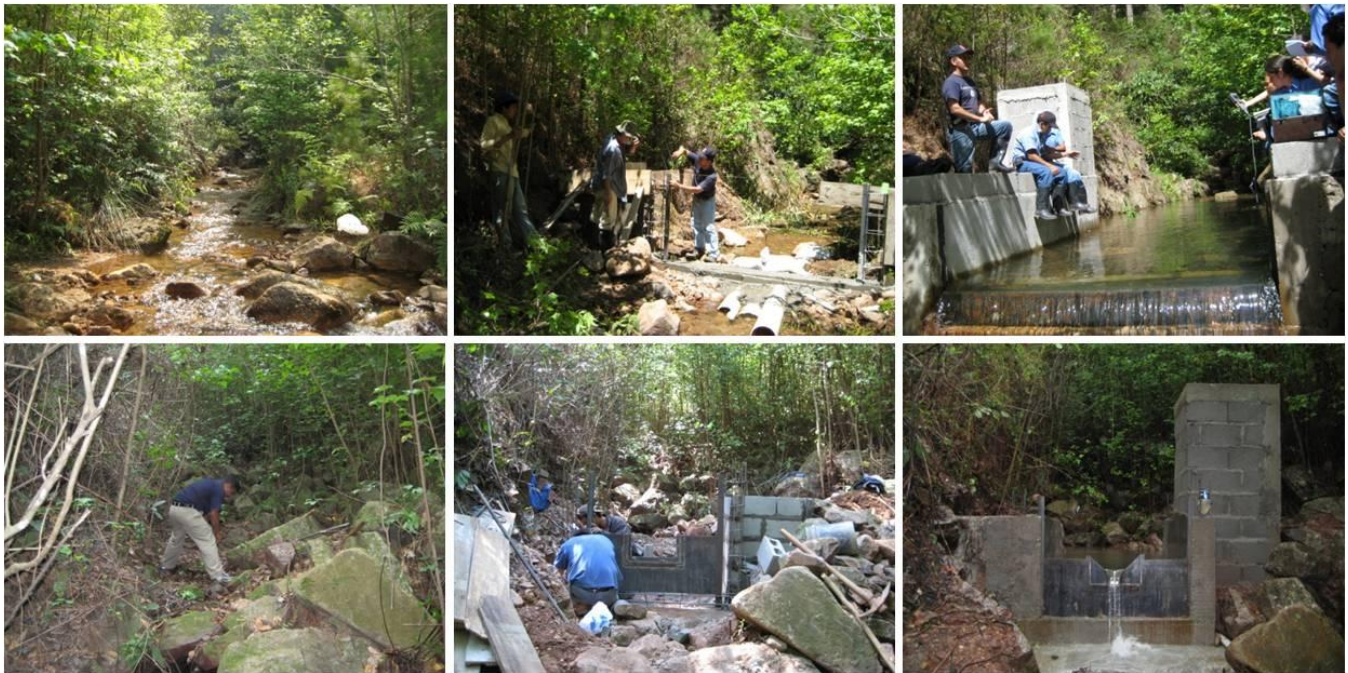
Figure 13. Vista del proceso de construcción de dos de los cuatro vertederos construidos. Tipo rectangular (WS1) arriba y tipo v-notch (WS3) abajo. Cuenca Experimental La Tigra, Honduras (Caballero, 2009).
