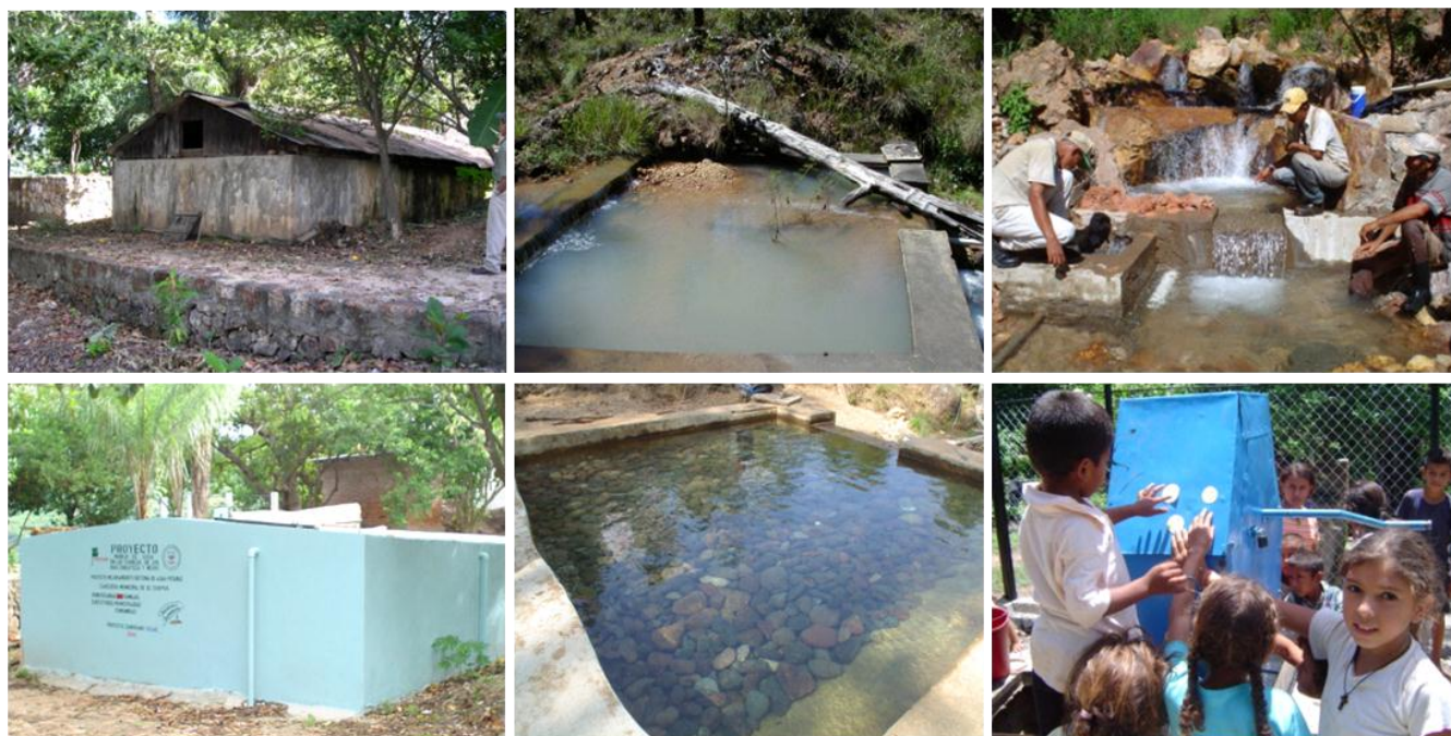
Figura 5. Algunos ejemplos de sistemas de agua potable reconstruidos y mejorados (foto arriba condición inicial, fotos abajo condición final) en la cuenca baja del Río Choluteca y Negro. Proyecto Manejo de Recursos Hídricos en la cuenca baja de los ríos Choluteca y Negro Zamorano/USAID (DSEA, 2005).
